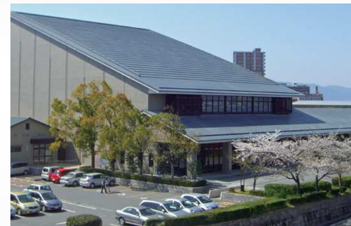
■県立草津文化芸術会館(滋賀県草津市) 材質:緑青銅板(現在は生産中止) ●設計/滋賀県建築設計管理事業協同組合 ●施工/(株)笹川組
