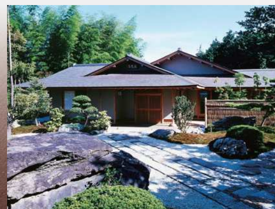
■伊勢の郷(三重県伊勢市) 材質:銅板 ●設計・施工/(株)新井組
