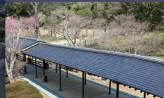
■新公会堂~シルクロード交流館渡り廊下(硫化銅板) ●設計/ (株)礎建築事務所 ●監理/ (有)森馬都市創造設計 ●施工/ (株)尾田組
