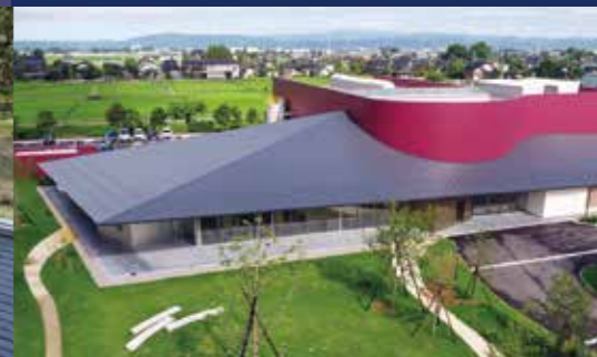
■株式会社能作 新社屋・工場(カラーGL鋼板) ●設計/ アーキヴィジョン広谷スタジオ ●施工/ 塩谷建設株式会社
