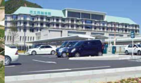
■西脇病院(フッ素GL鋼板) ●設計/ (株)日建設 ●施工/ 三井住友・安藤建設特定建設共同企業体
