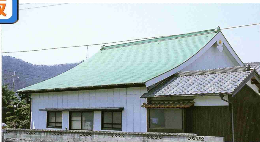
●施工後/ガルバリウム鋼板耐摩緑青色使用
