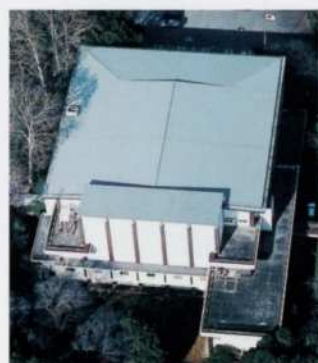
■明治神宮会館屋根改修工事(東京都)
