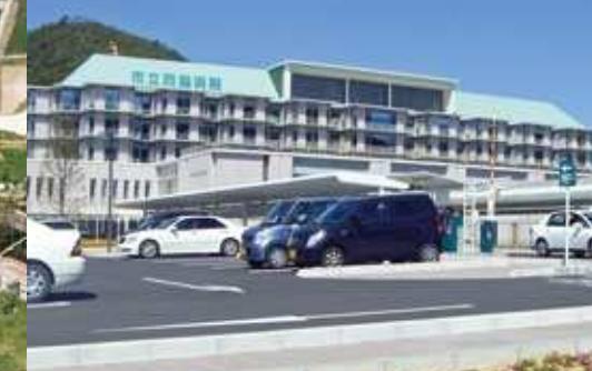
■西脇病院（フッ素GL鋼板） ●設計／(株)日建設 ●施工／三井住友・安藤建設特定建設共同企業体
