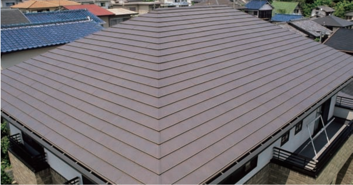
■学園前の家(改修工事) 材質:銅板 板厚0.5mm
