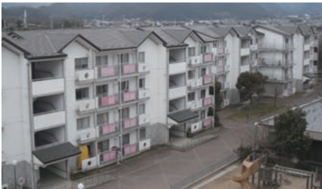
■京都府営穴川団地(平成21・22年度) 材質:遮熱鋼板ギングロ ●設計/京都府南丹土木事務所 ●施工/株式会社三煌産業
