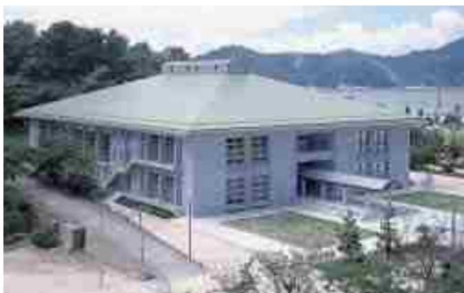
海上保安大学校体育館 (広島)
