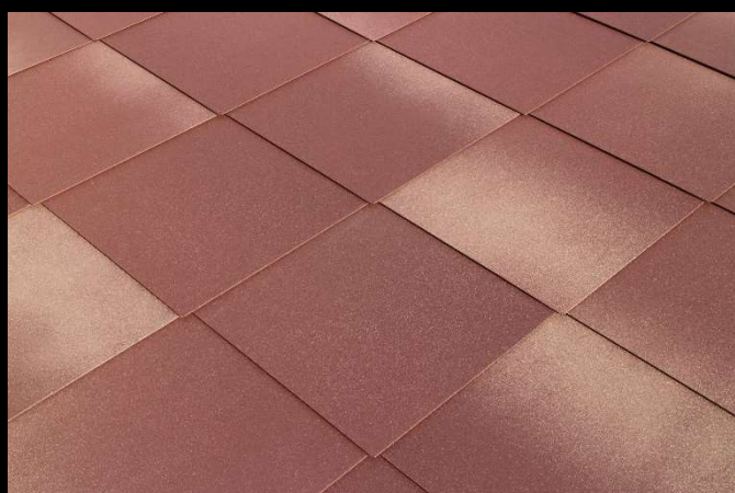
施工例 菱葺 455 型 ブリック
