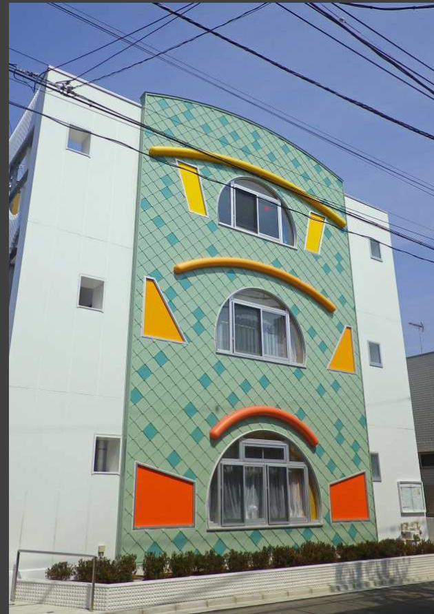
日の出保育園某事務所ビル
